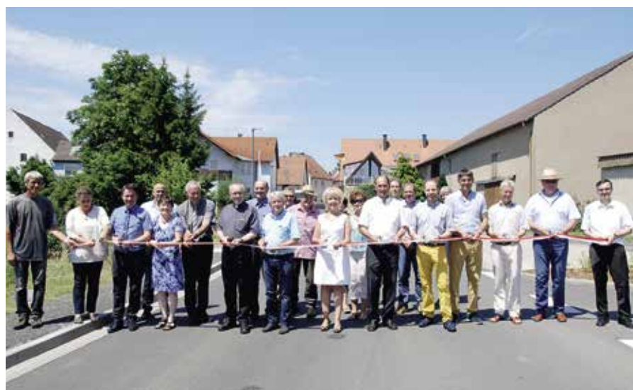
Auf 480 Metern wurde die KT 22 in Biebelried erneuert. Die Gemeinde schloss die Sanierung der Gehwege sowie der Kanal- und Wasserleitungen an.
