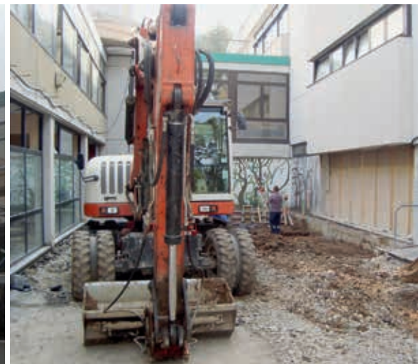
Vorarbeiten für den Aufzug
