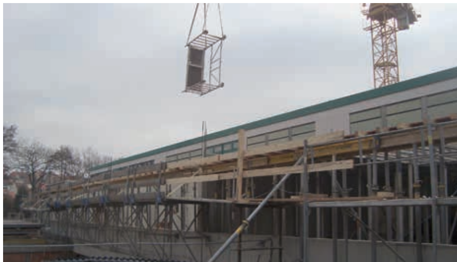
Arbeiten am Erweiterungsbau
